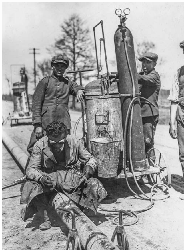
Spawanie gazociągu do Lwowa.
