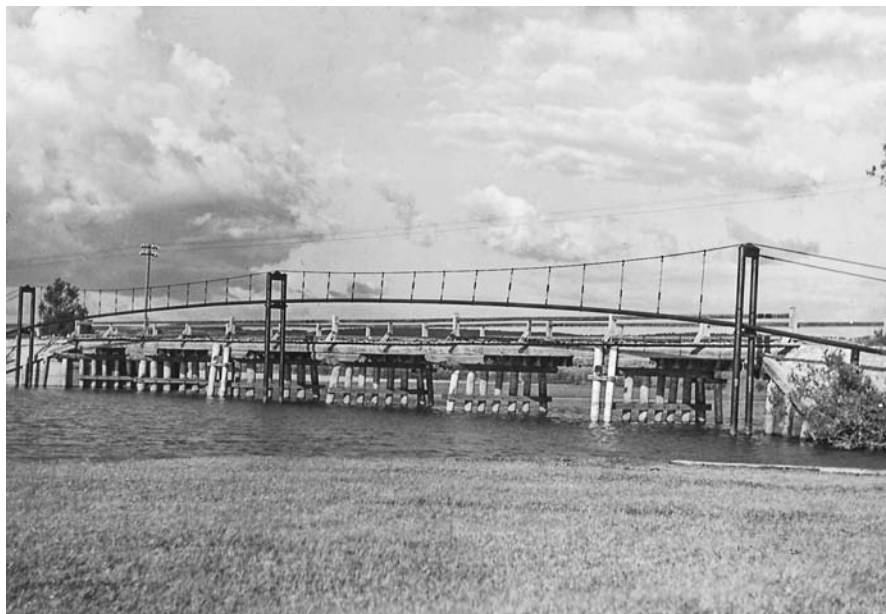
Stary most gazociągowy nad Brydnicą.
