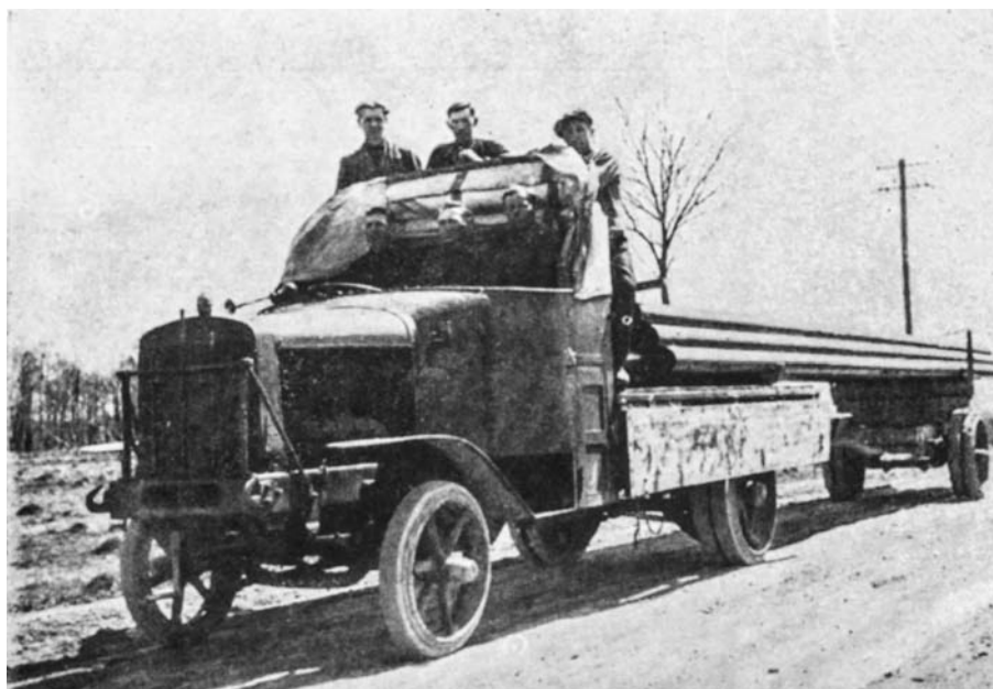
Budowa gazociągu do Lwowa. — Transport rur.
