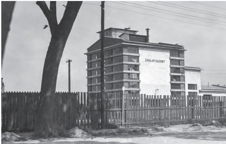
Gdynia, ul. Chyłońska 110, hala generatorów Zakładu Gazowego w Gdyni (nieistniejąca) w latach 30., proj. Jerzy Müller, 1931 r. Źródło: Muzeum Miasta Gdyni
