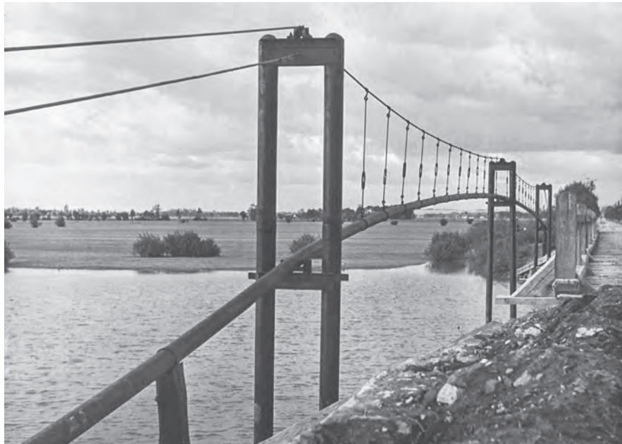
Most linowy dla podwieszenia gazociągu na rzece Dniestr niedaleko Rozwadowa Źródło: Archiwum Brwinów
